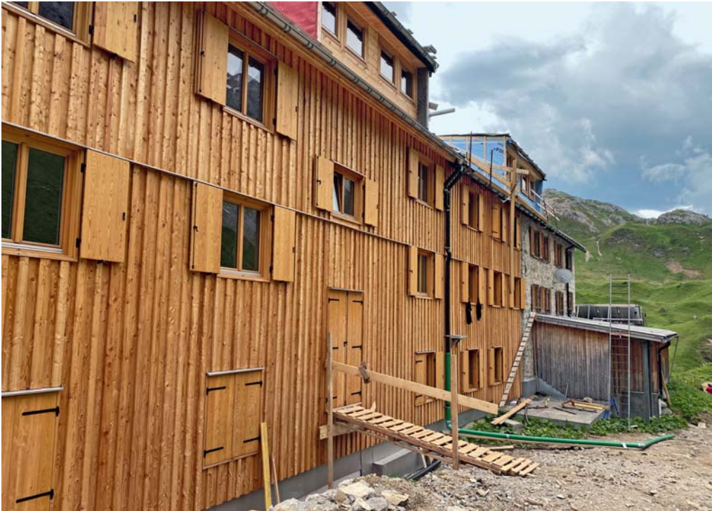
Umbau der Kemptner Hütte
